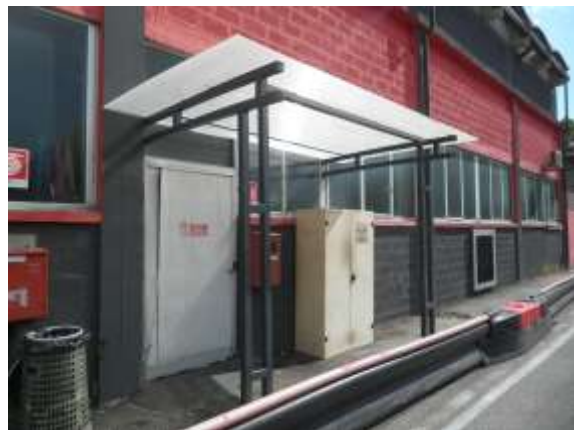
Box di deposito carburante (benzina senza piombo).
