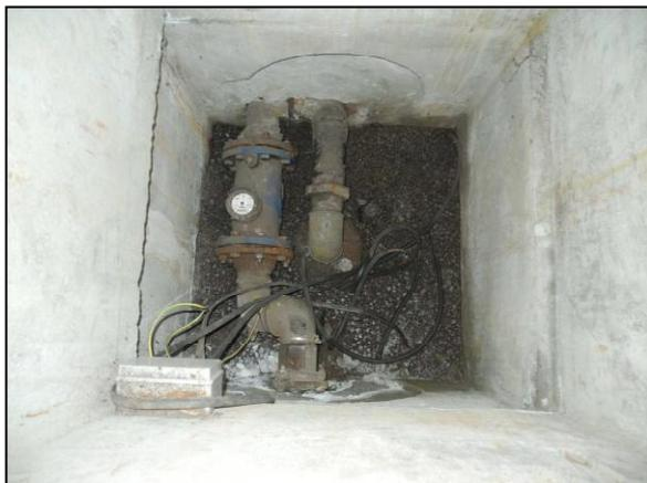
**Foto 1: Pozzettone di contenimento testa pozzo**
