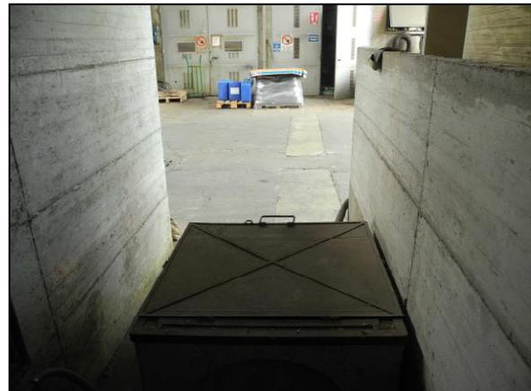
**Foto 6 e Foto 7: Coperchio metallico per chiusura pozzettone**
