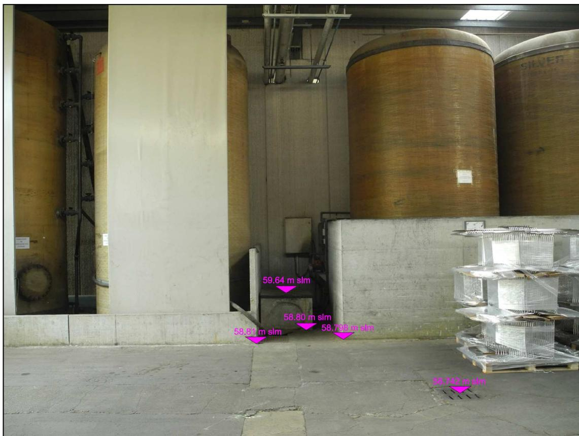
**Foto 8: Quote assolute pozzettone e piano calpestio del capannone**
