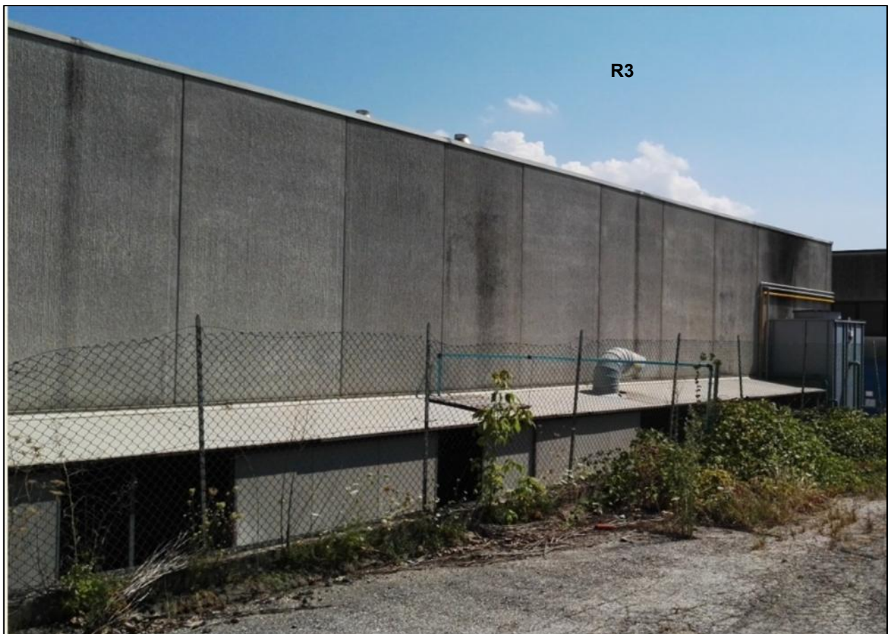
Foto n.3: Ricettore R3 con impianti lato ovest – facciata verso area di progetto
