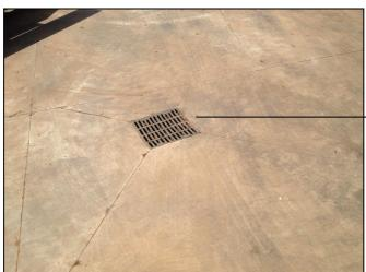
pozzetto con griglia per smaltimento acque meteoriche nell'apposita rete
