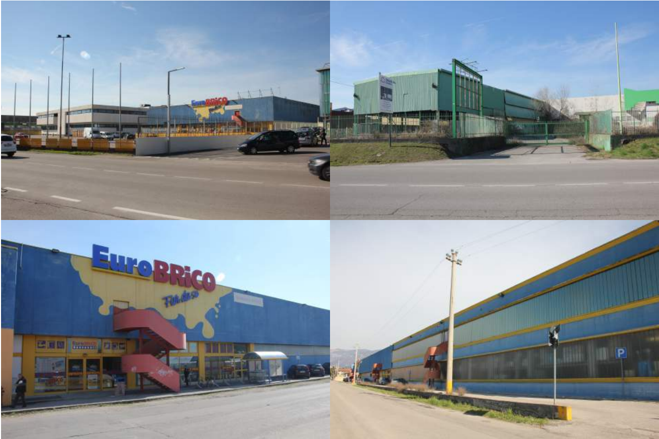
Figura 3 – Immagini dello stato di fatto
