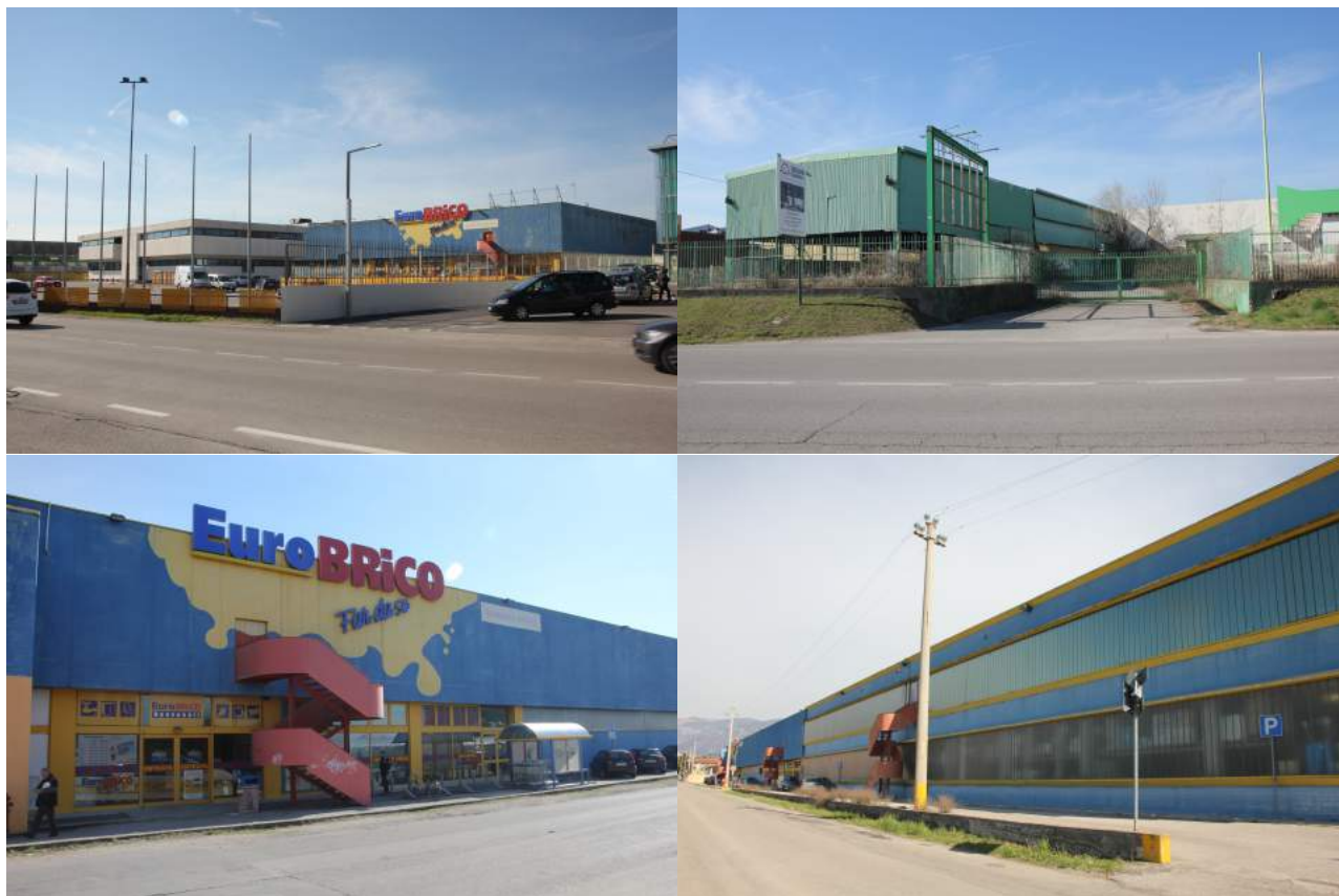
Figura 3.5 – Immagini dello stato di fatto
