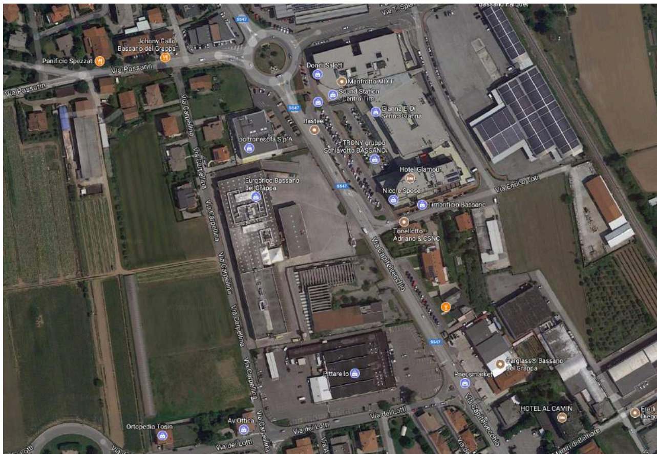
Figura n. 4.2.1 - Aerofotogrammetria dell'area in cui si inserirà il nuovo fabbricato
