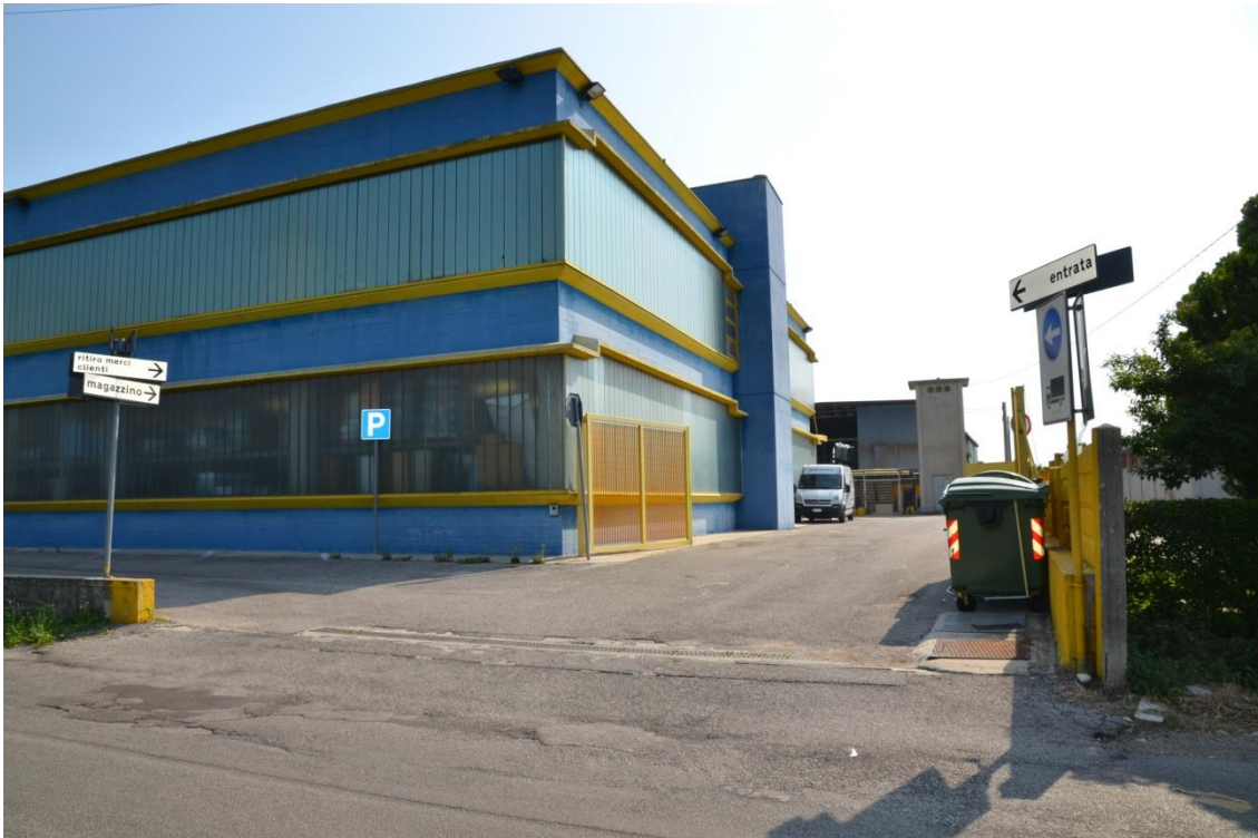
FOTO N. 5 - VISTA DA OVEST DEL CONFINE SUD DELL'AREA DI INTERVENTO.
