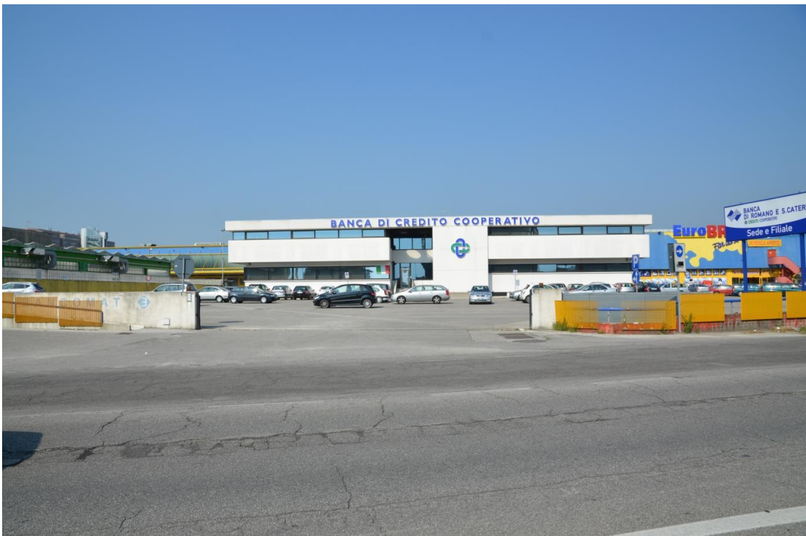
FOTO N. 6 - VISTA DA EST CON ACCESSO ALL'AREA DI INTERVENTO DA VIA CAPITELVECCHIO
