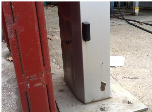
In caso di black out è possibile sbloccare la frizione (mediante apposita chiave presente in ufficio pesa e in ufficio) e azionare a mano la sbarra.
