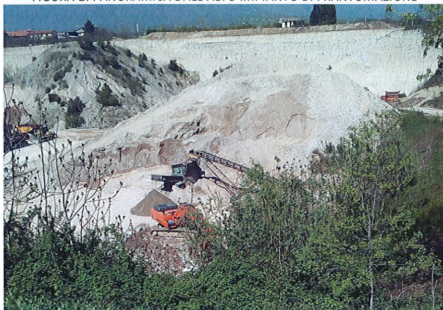
FIGURA 2: PANORAMICA DALL'ALTO IMPIANTO DI FRANTUMAZIONE
