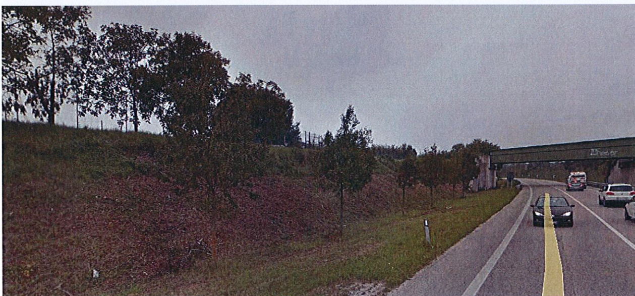
FOTO 2: Collegamento Thiene-Schio, presso punto B dell'immagine precedente
