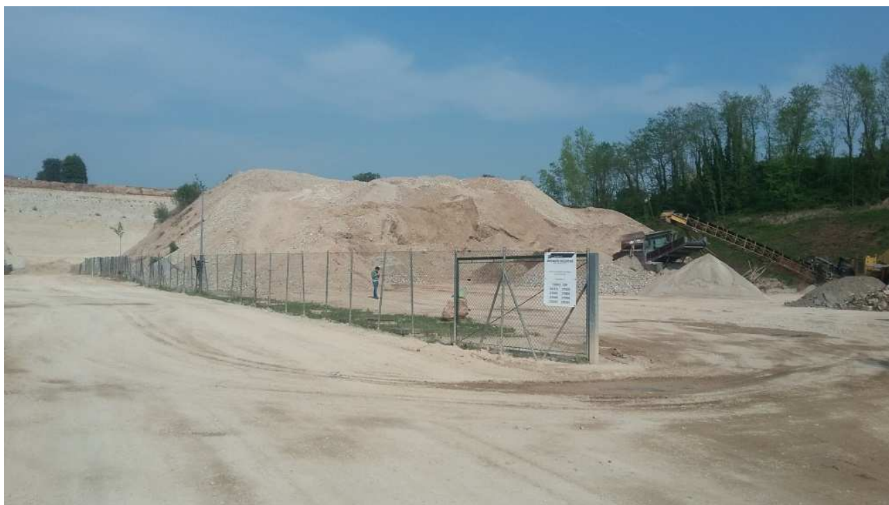
Figura 7 – Vista recinzione dell'impianto e cumulo di MPS in area "F1". Cono visuale CV_5
