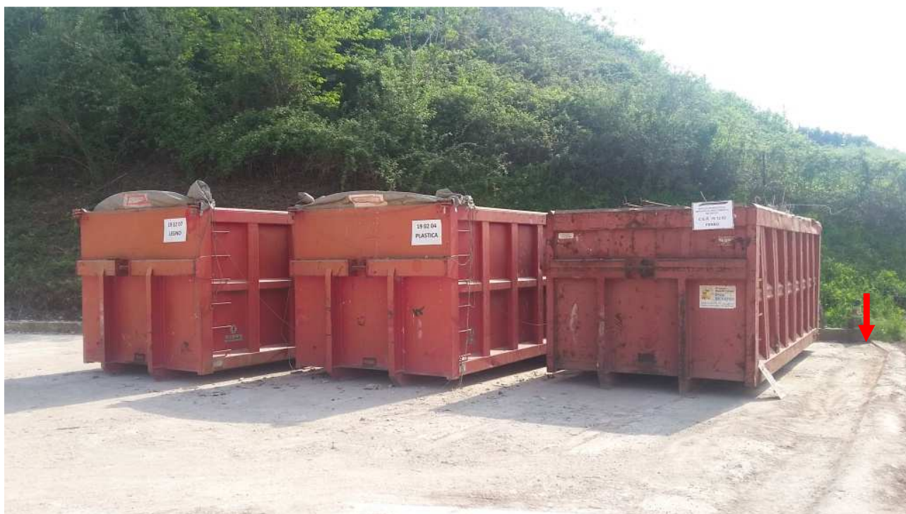
Figura 5 – Particolare dei cassoni di stoccaggio rifiuti prodotti dall'impianto, di cui alla precedente foto, e della canaletta perimetrale di raccolta delle acque di dilavamento (freccia rossa). Cono visuale CV_3
