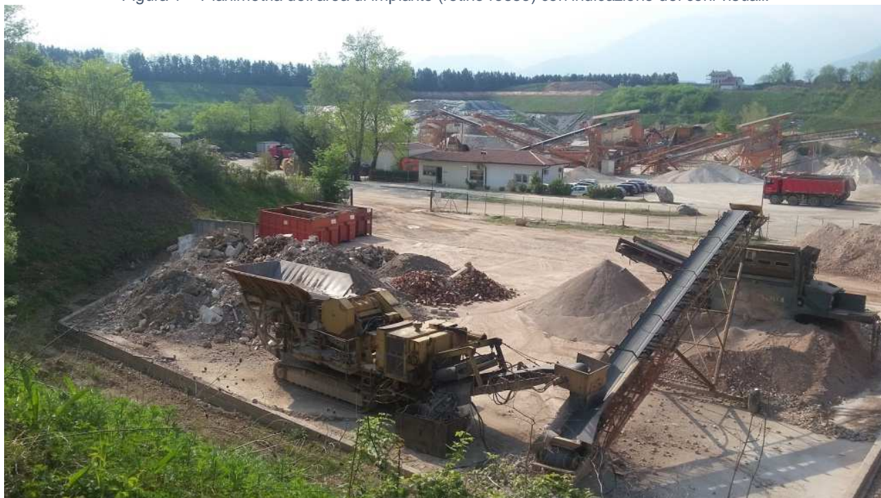
Figura 2 – Panoramica dell'impianto, con impianti su area pavimentata, a sinistra area "A" per i rifiuti in R13 e a destra area "E" per i cumuli di materiale lavorato Cono visuale CV_1
