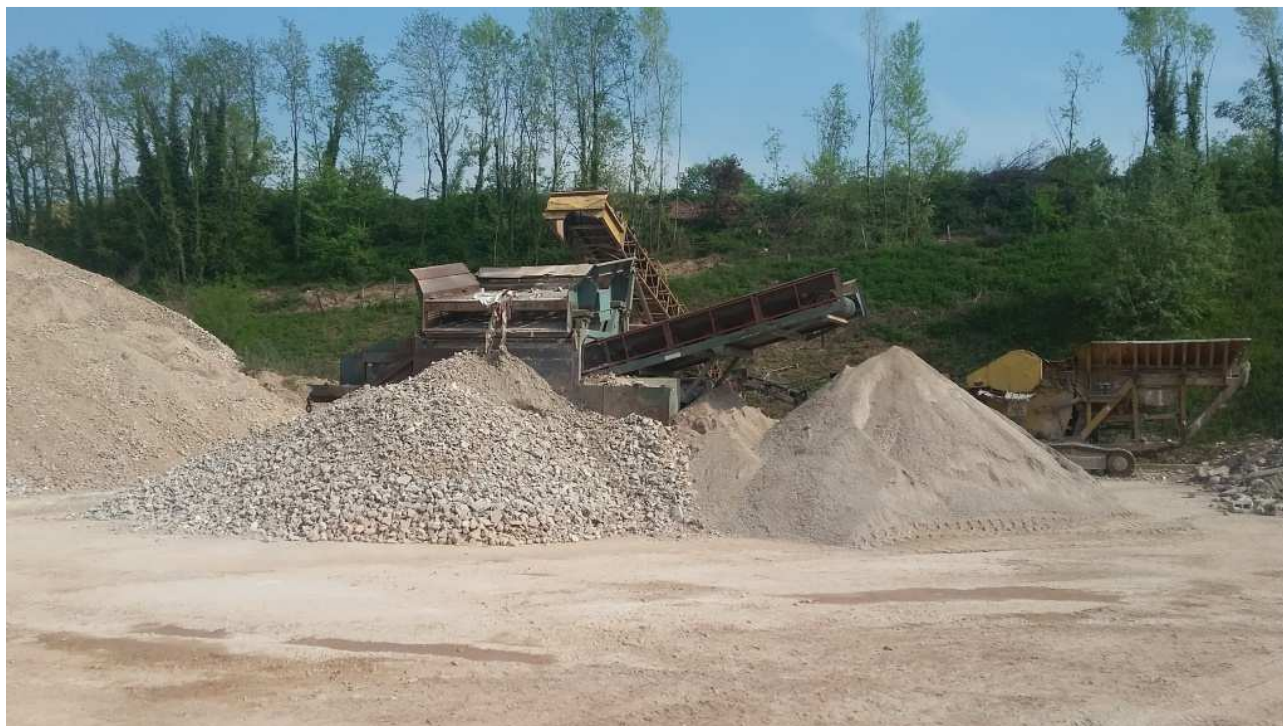
Figura 10 – Altra visuale dell'area "E" pavimentata, con il materiale frantumato e selezionato; sulla sinistra il cumulo di MPS. Cono visuale CV_8
