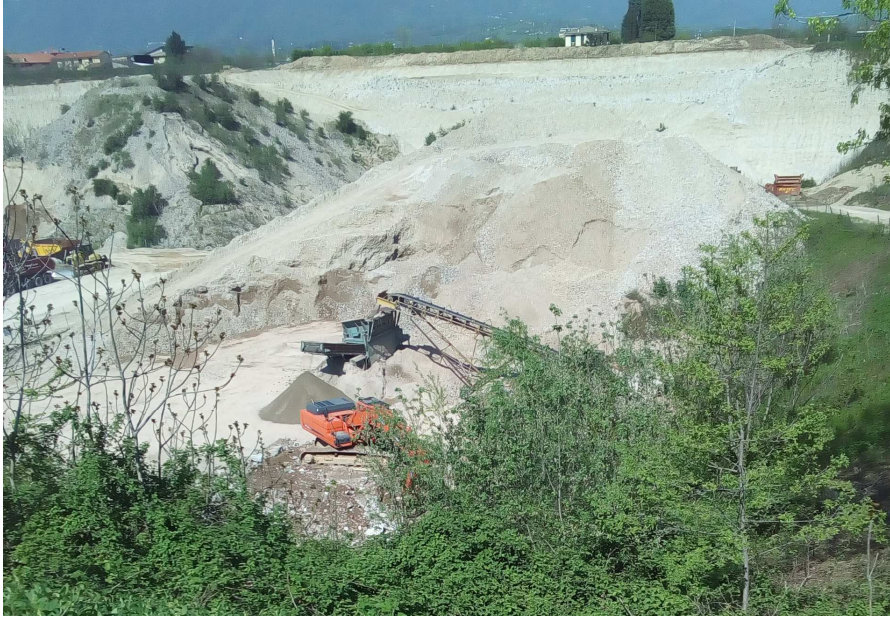
FIGURA 2: PANORAMICA DALL'ALTO IMPIANTO DI FRANTUMAZIONE
