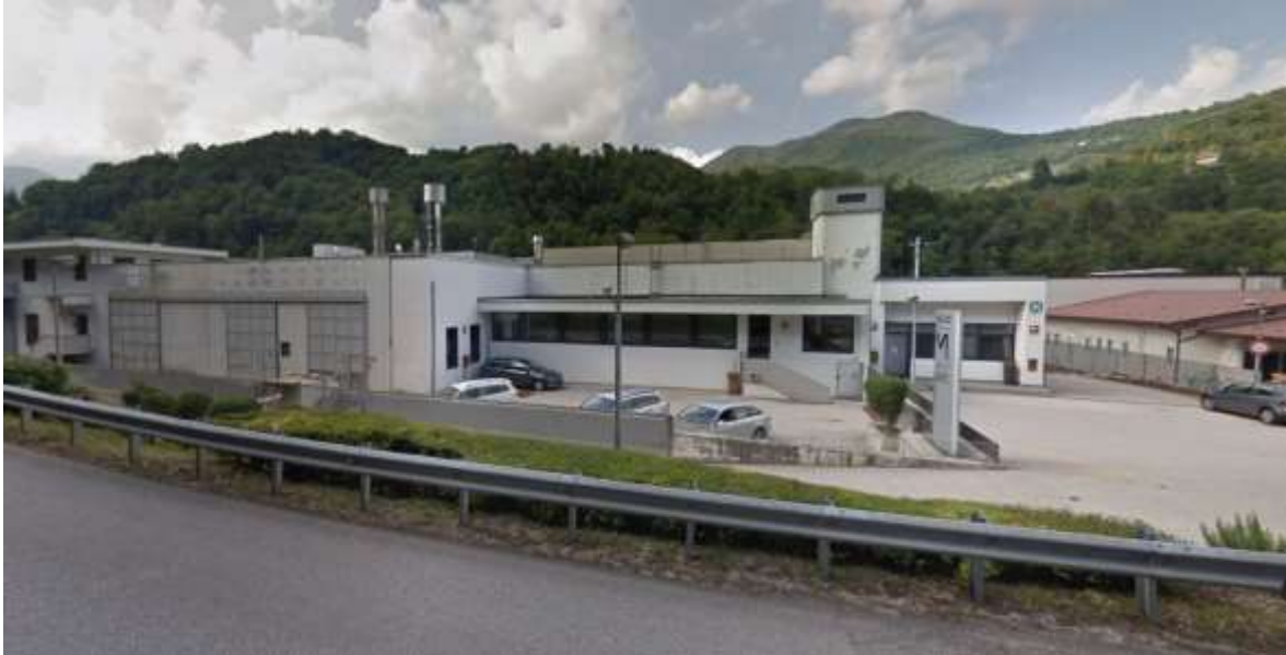
Figura 49: Vista dell'impianto in esame
