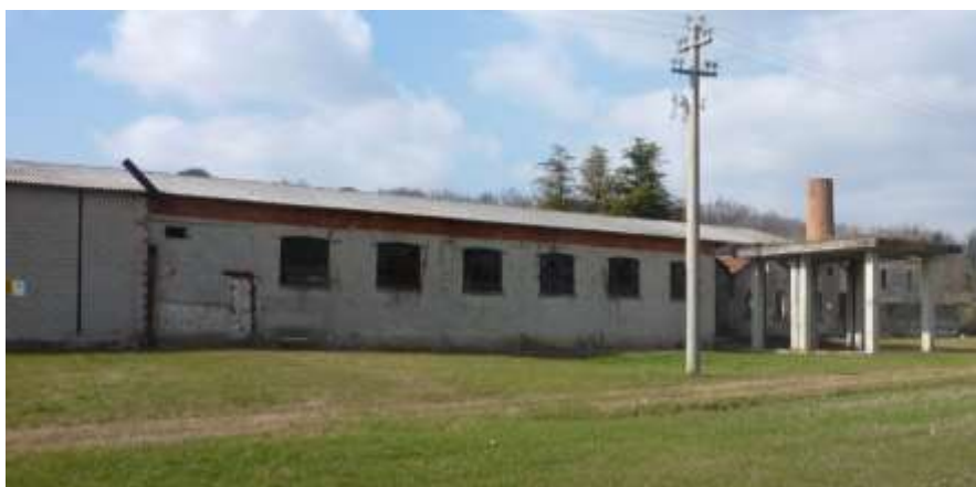
Figura 7: Vista della parte retrostante dell'Ex lanificio.
