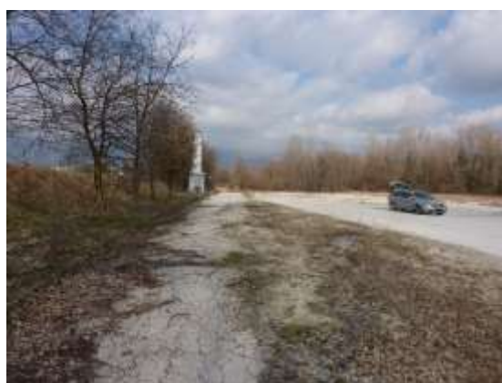
Argine esistente con fascia arborea da potenziare
