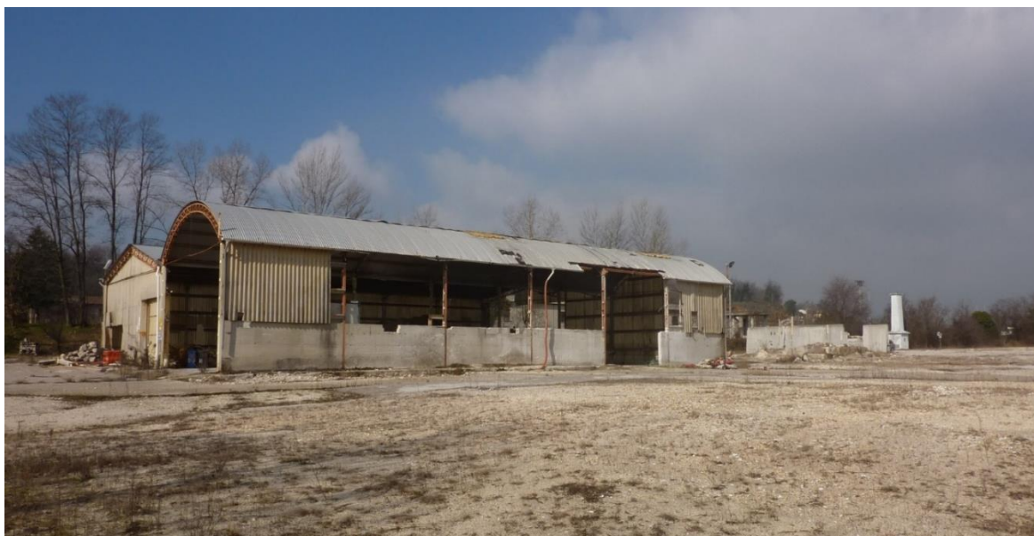
Figura 16: Stato di fatto vista del capannone esistente dal piazzale interno
