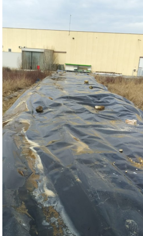
Vista del cumulo coperto con telo in HDPE
