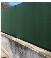
Barriera con rete antipolvere (h m 2 + 1,5 m muro di cinta esistente) proposta
