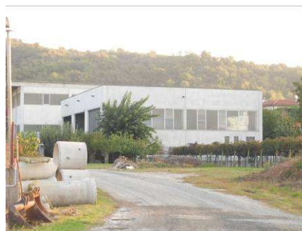
Foto 1-2 : capannoni di deposito
