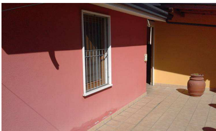
Foto n. 17 : Locale Bagno piano primo del ricettore R2 (In facciata alla Ditta Maule s.r.l.)
