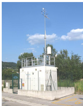
Stazione fissa ARPAV di Chiampo
