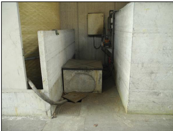
Foto 6 e Foto 7: Coperchio metallico per chiusura pozzettone
