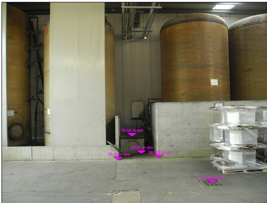
Foto 8: Quote assolute pozzettone e piano calpestio del capannone
