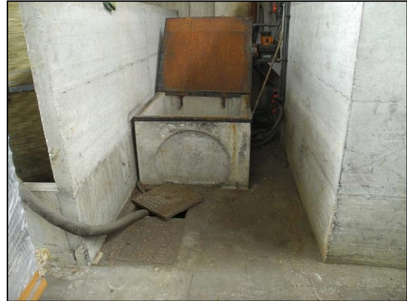
Foto 2: Pozzettone fuori terra con coperchio metallico
