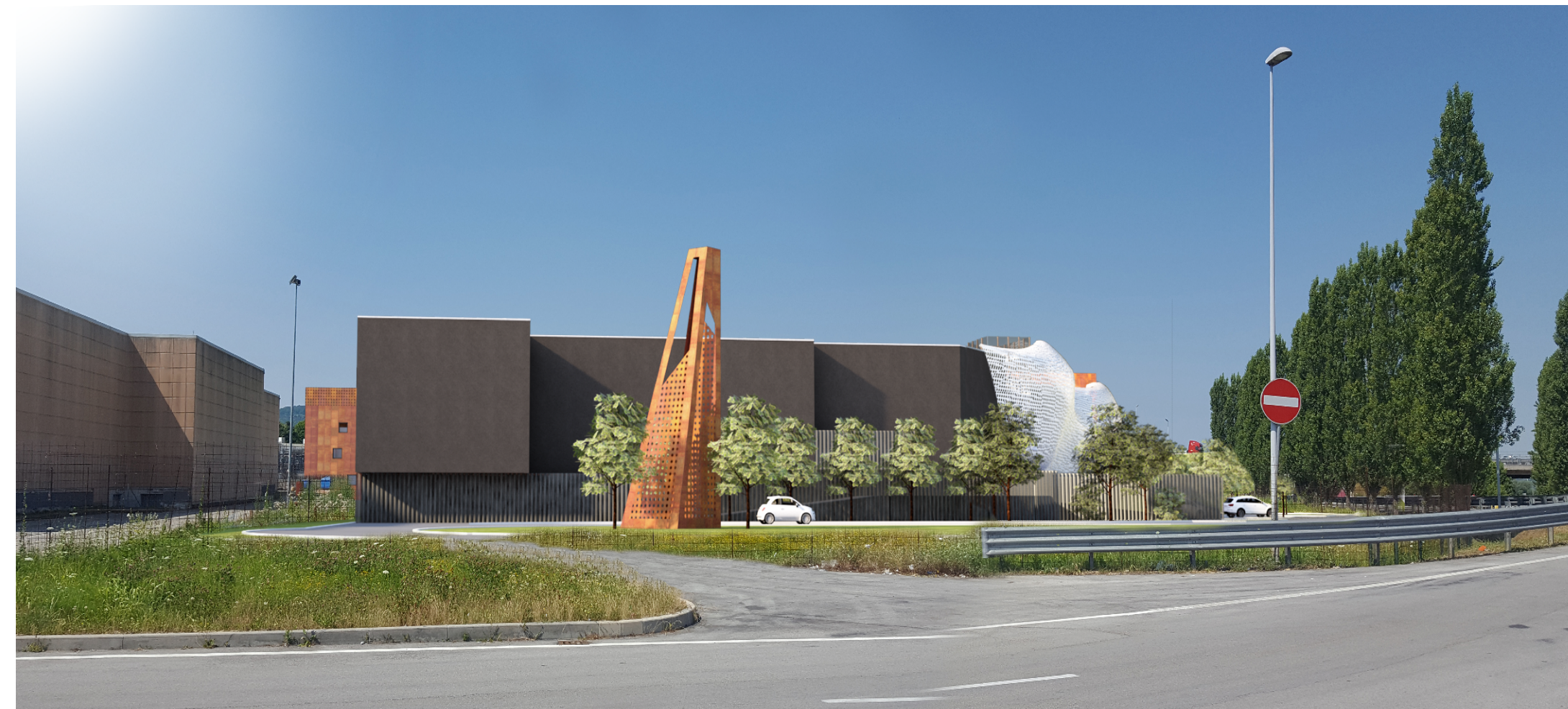
VISTA DA VIA VERCELLI
