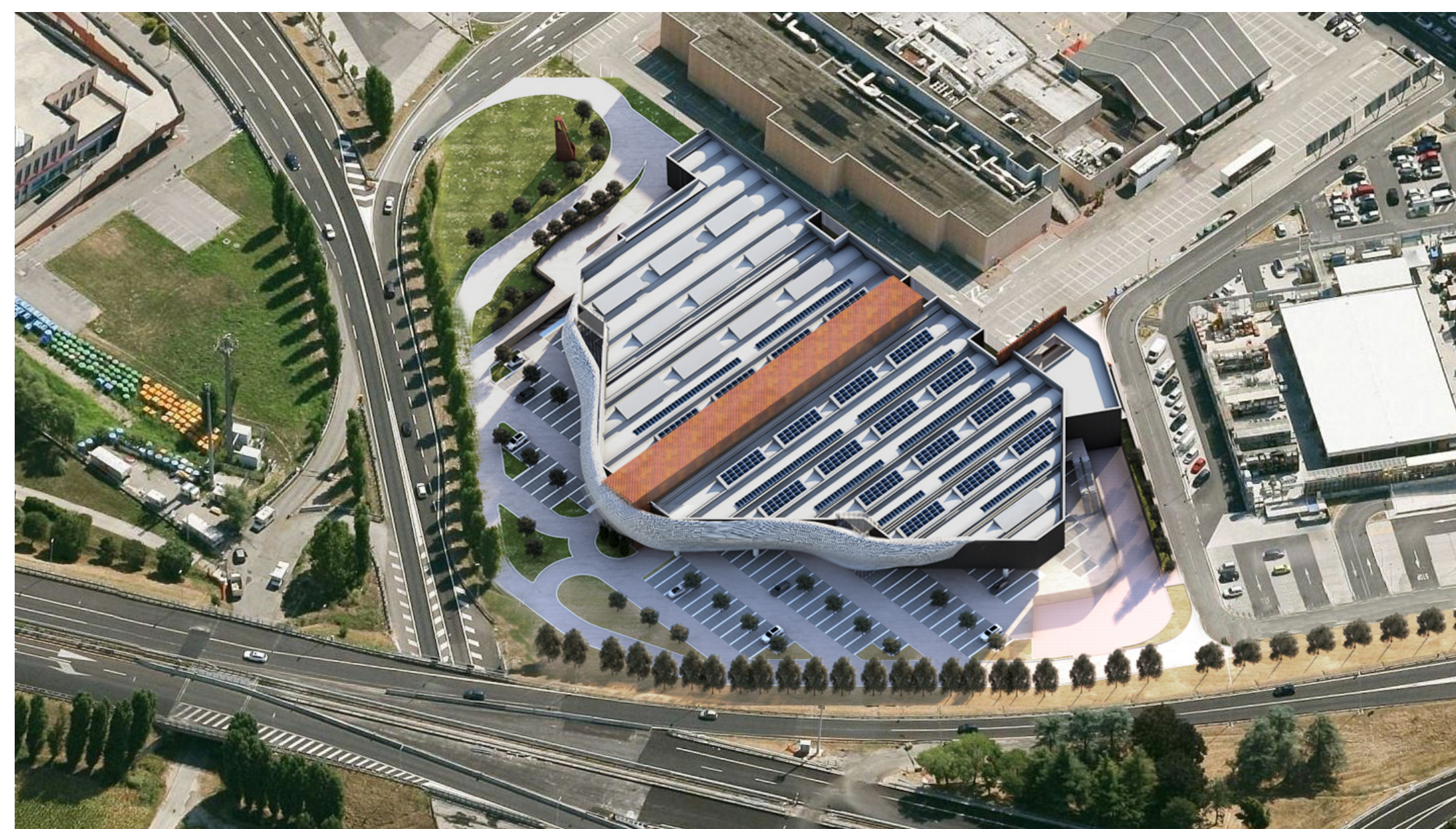
VISTA AEREA DELL'INTERVENTO E DEL CONTESTO
