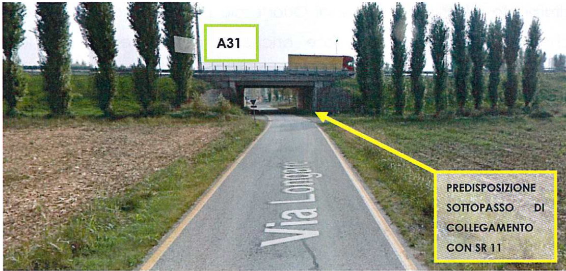
Sottopasso A31 – vista da Via Longare (SP 27)
