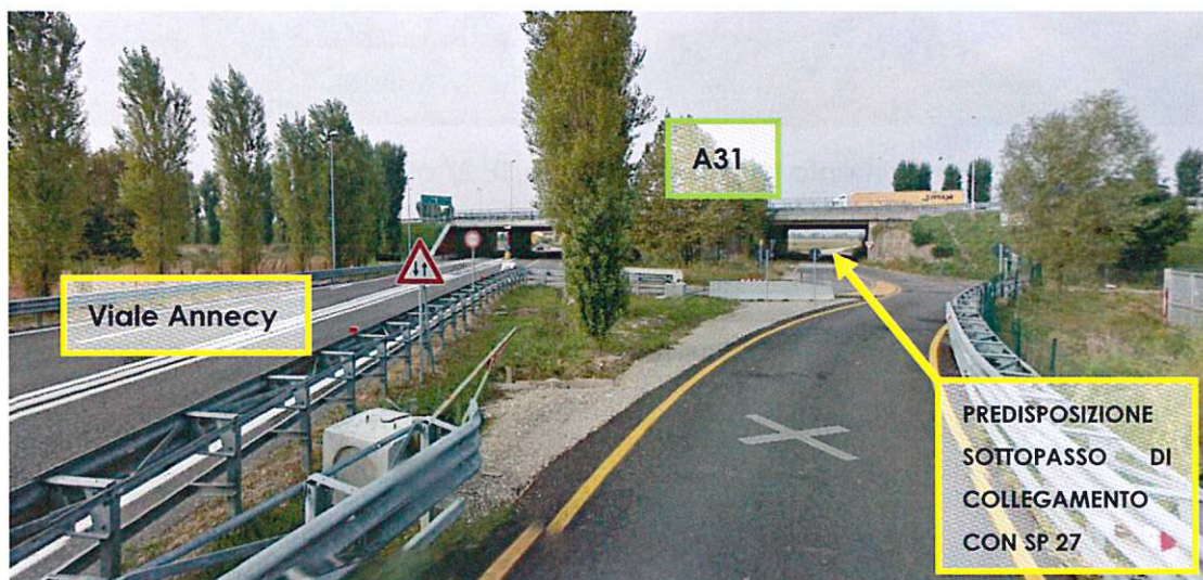
Sottopasso A31 – vista da Viale Annecy
