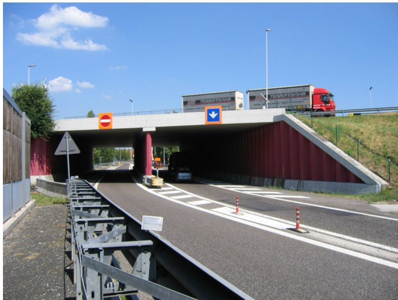
Figura 31 - Vista n. 1 del sottopasso del viadotto in direzione Padova
