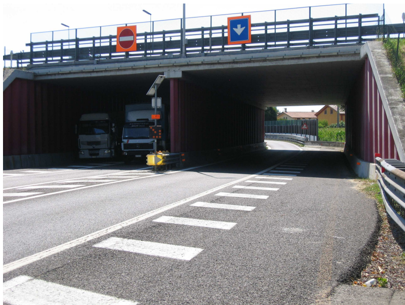
Figura 32 - Vista n. 2 del sottopasso del viadotto in direzione Vicenza
