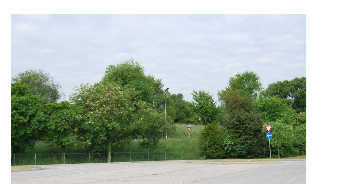
FOTO 11 MITIGAZIONE SU SVINCOLO AUTOSTRADALE
