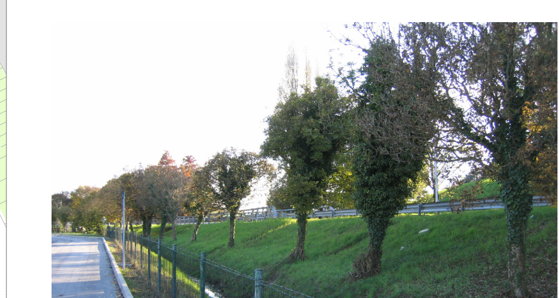
FOTO 5 QUINTA VEGETATIVA DI SEPARAZIONE CON RACCORDO AUTOSTRADALE
