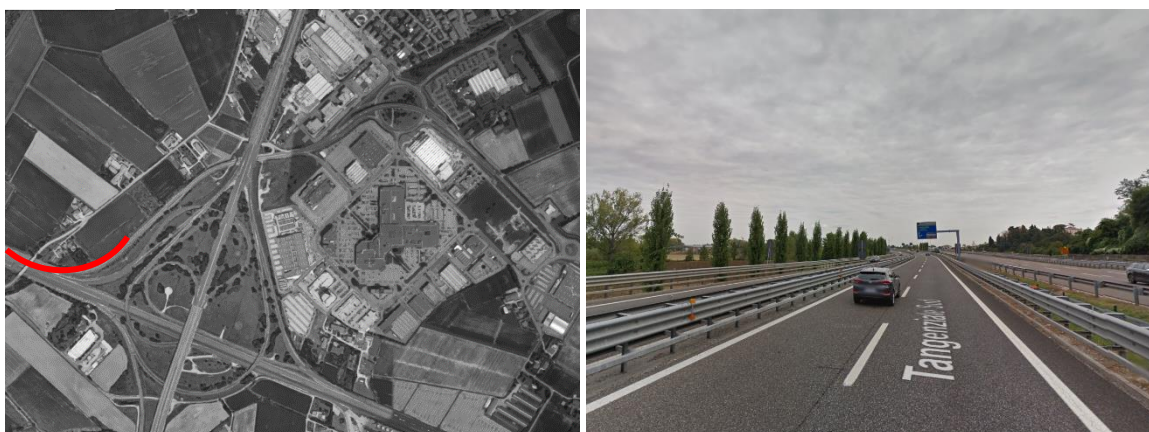
Figura 8: Localizzazione e foto della tangenziale sud di Vicenza
