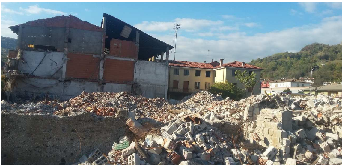
Figura 3 – Vista dell'area in demolizione in direzione dei fabbricati in capo alla ditta L.O.D. srl, cono visuale CV_2
