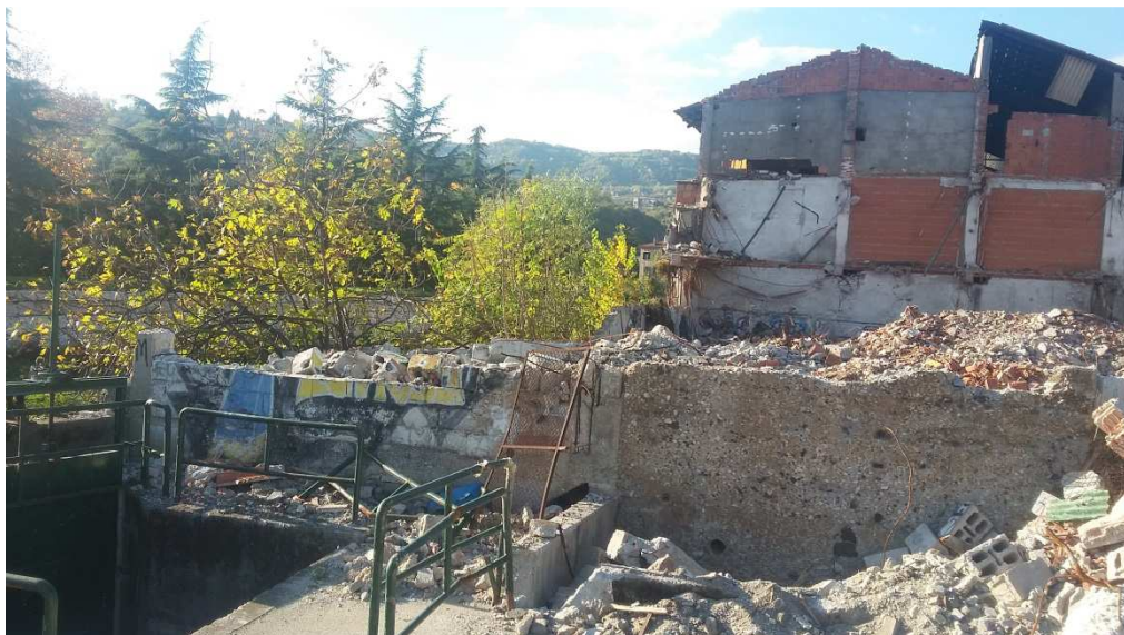
Figura 7 - Particolare opera di presa presente all'interno del cantiere
