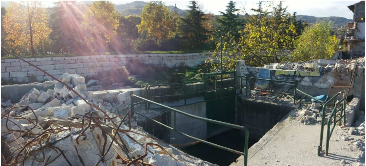
Figura 6 – Particolare opera di presa presente all'interno del cantiere
