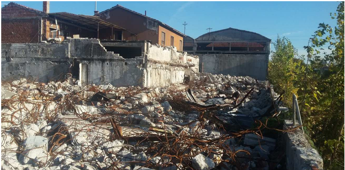
Figura 16 – Materiale di demolizione, cono visuale CV_7
