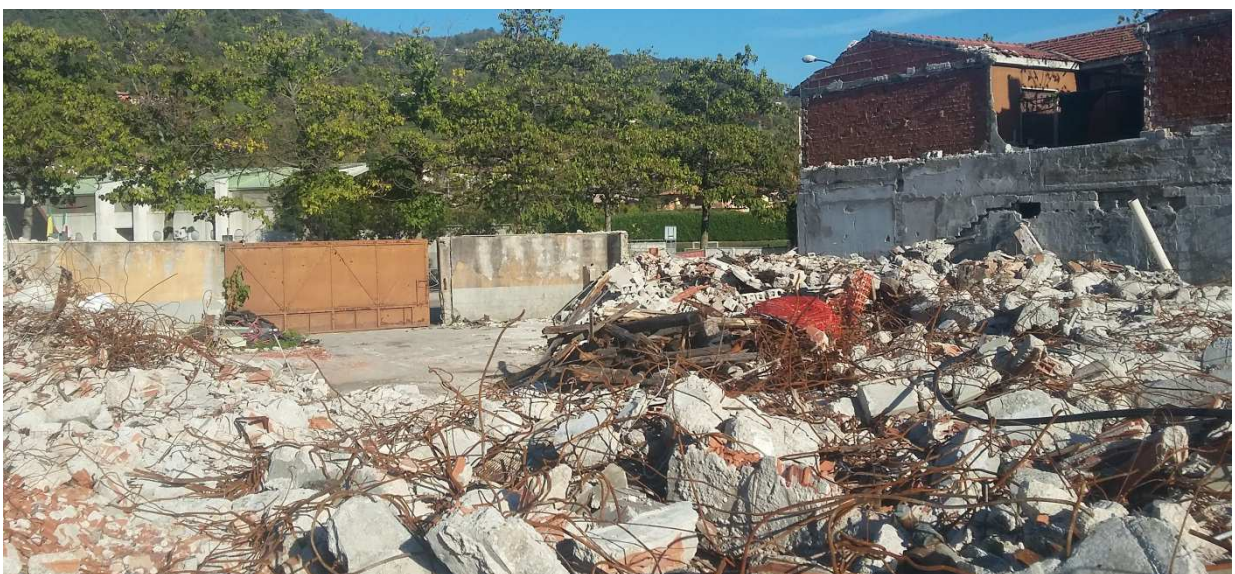
Figura 17-Cancello di entrata al cantiere
