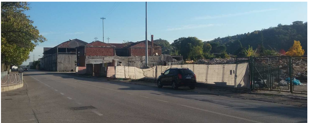
Figura 2 – Panoramica del cantiere dall'incroci tra via Pace e via Alcide de Gasperi, cono visuale CV_1
