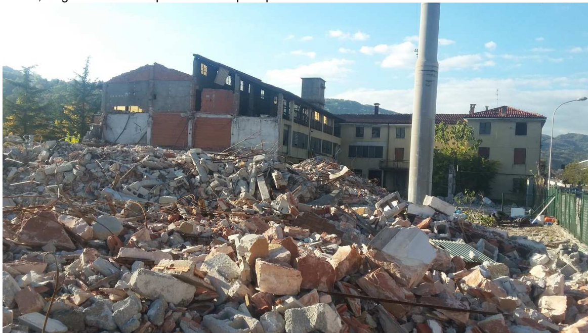
Figura 6 - vista cumulo di demolizione degli edifici in area FDB Sas
