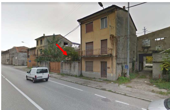
Figura 4 :- vista degli edifici della F.D.B. srl, da Via Pace, prima della demolizione (freccia rossa)
