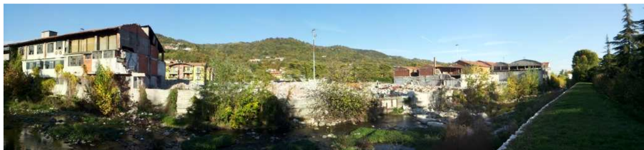
Figura 58 – panoramica attuale degli edifici demoliti di Via Pace 104 dalla sponda DX del Torrente Chiampo
