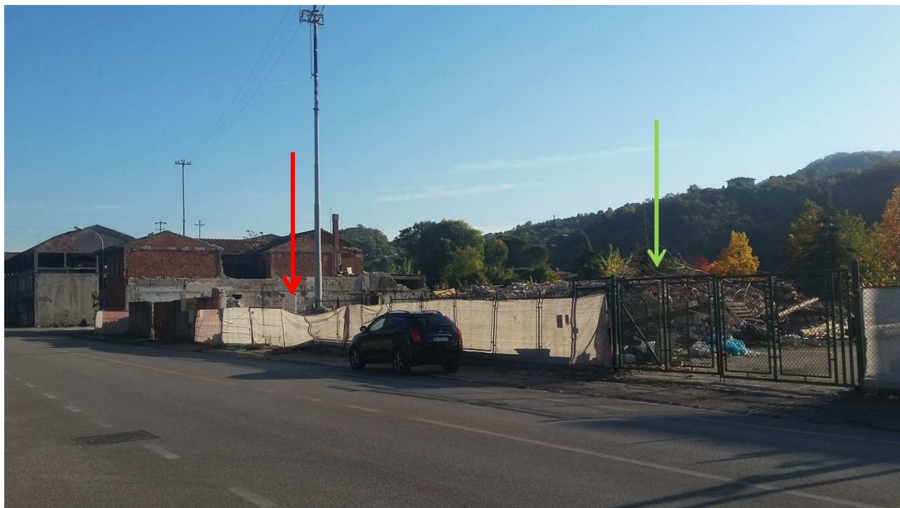
Figura 6 : vista di Via Pace, dopo la demolizione degli edifici della F.D.B. srl (freccia rossa) e dell'Immobiliare L.O.D. srl (freccia verde) , con messa in opera di recinzione temporanea
