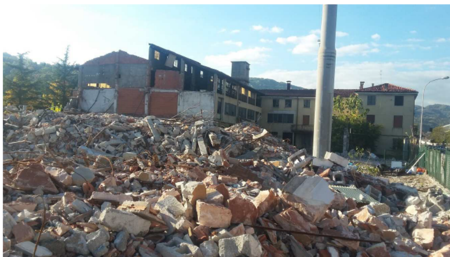
Figura 8: vista cumulo di demolizione degli edifici in area FDB Sas
