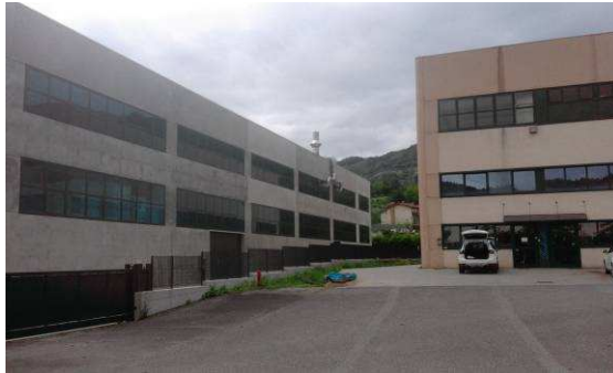
Foto n.17 : Impianti esterni delle Ditte di zona
