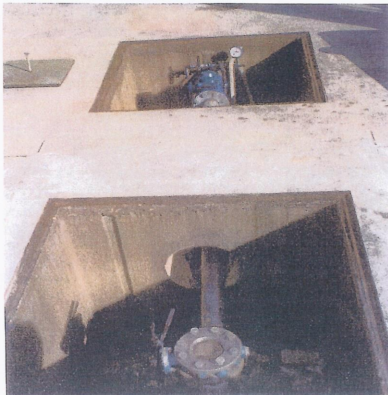
FOTO n° 2 : veduta d'assieme dei due pozzetti : nel primo, è presente la saracinesca di regolazione, nel secondo, il contatore Woltmann;
