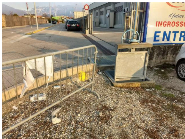
Vista del pozzetto d'ispezione/chiusura della canaletta a sud del Grifone
