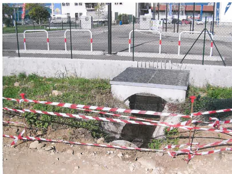
*foto 2: pozzetto di uscita del sifone esistente*
