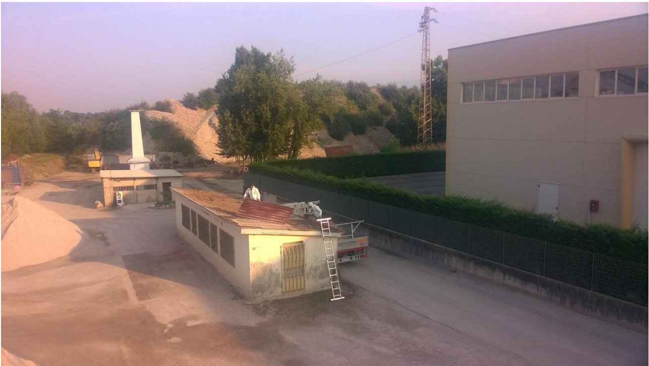
Figura 2 Operazioni di smaltimento amianto tettoia
