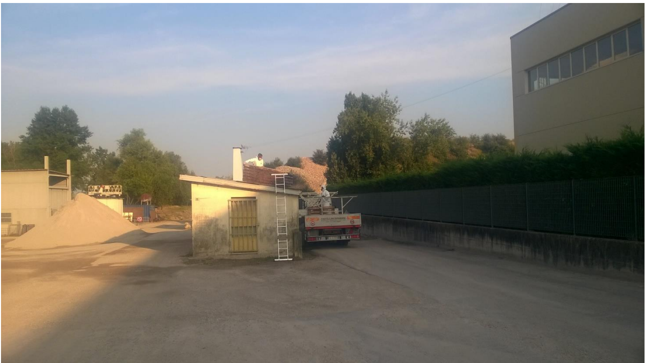
Figura 3 Operazioni di smaltimento amianto tettoia
