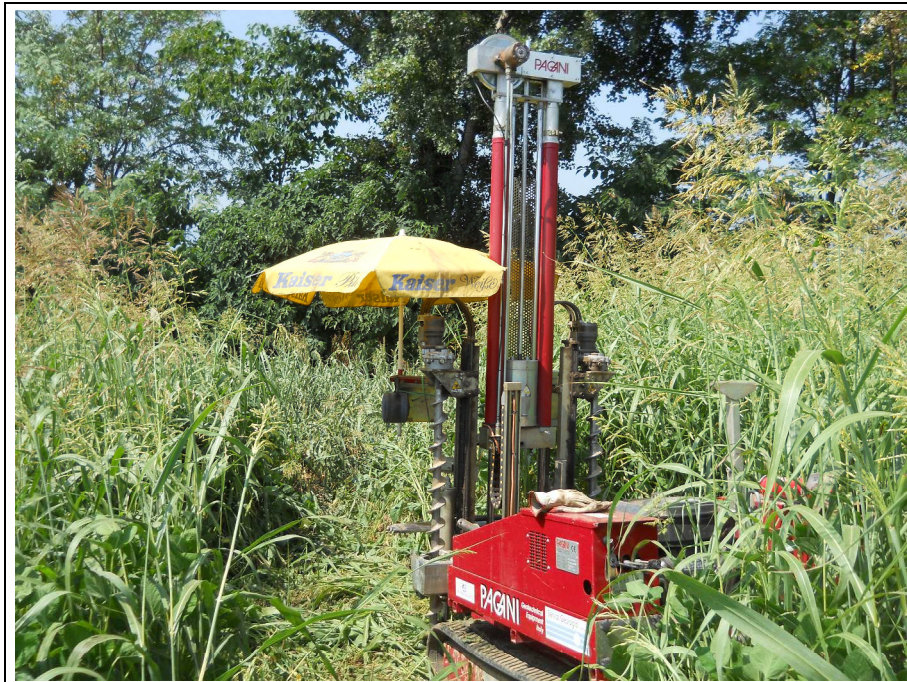
Foto 4: Esecuzione della prova DPSH4
