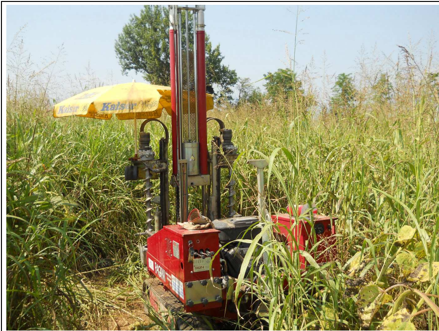
Foto 6: Esecuzione della prova DPSH6
