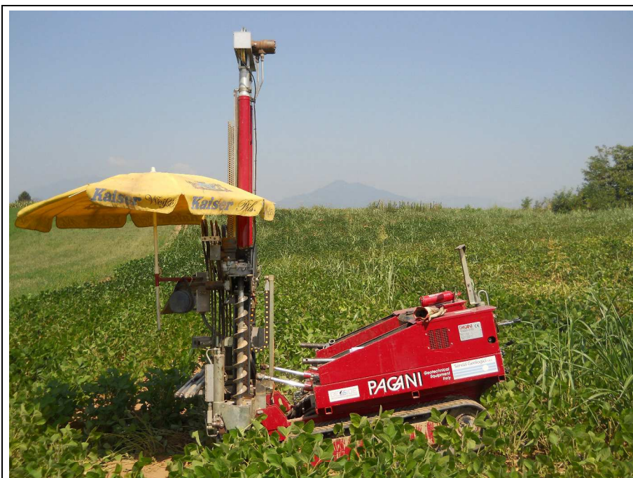
Foto 2: Esecuzione della prova DPSH2
