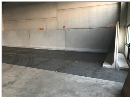
Cono 6 - Area messa in riserva R13 in cumulo
