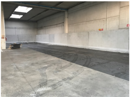
Cono 5 - Area messa in riserva R13 in cumulo
