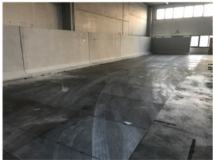
Cono 3 - Area messa in riserva R13 in cumulo
