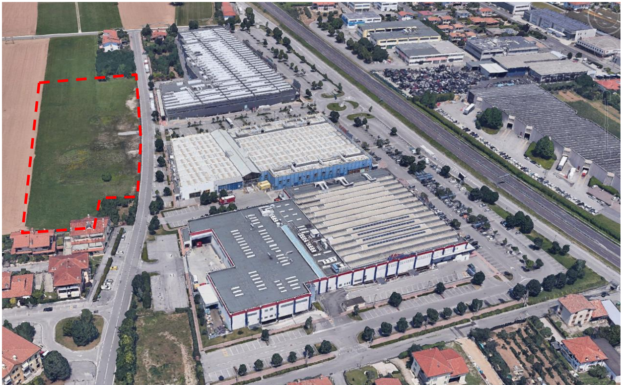
Figura 2-4. Visuale del Parco Commerciale dal punto di ripresa 3 (Fonte: Google Earth 2017)
