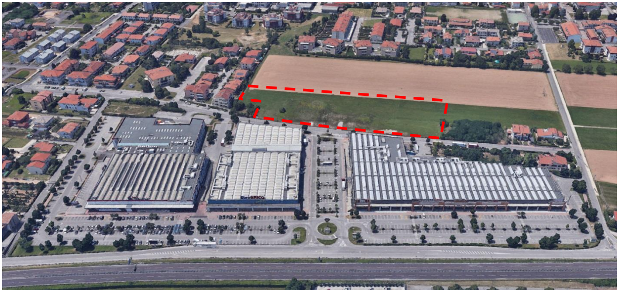
Figura 2-3. Visuale del Parco Commerciale dal punto di ripresa 2 (Fonte: Google Earth 2017)
