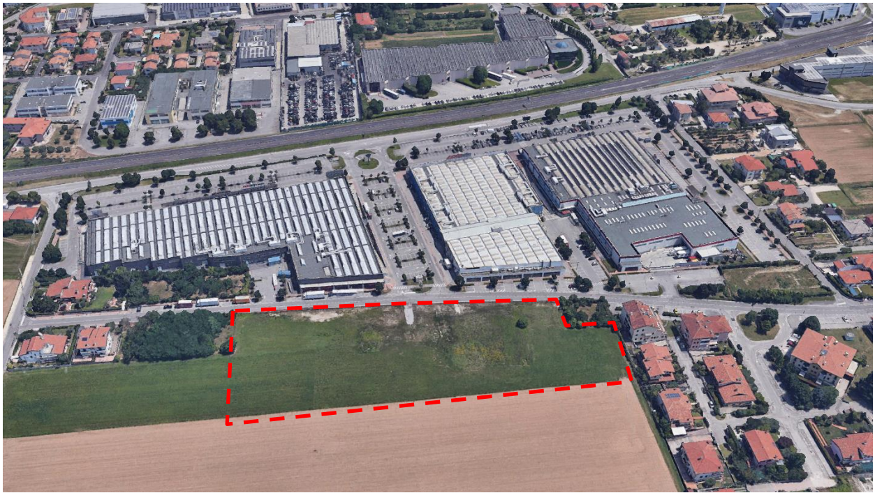
Figura 2-2. Visuale del Parco Commerciale dal punto di ripresa 1 (Fonte: Google Earth 2017)
