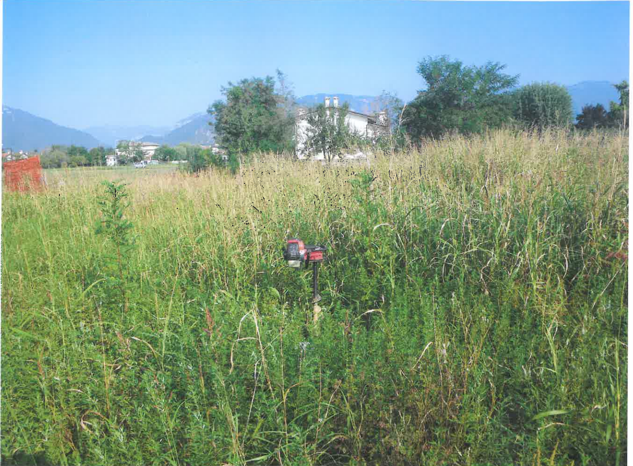
Foto N.1 : Esecuzione del Sondaggio ambientale N.1 con trivella motorizzata nell'area dell'impianto carburanti
