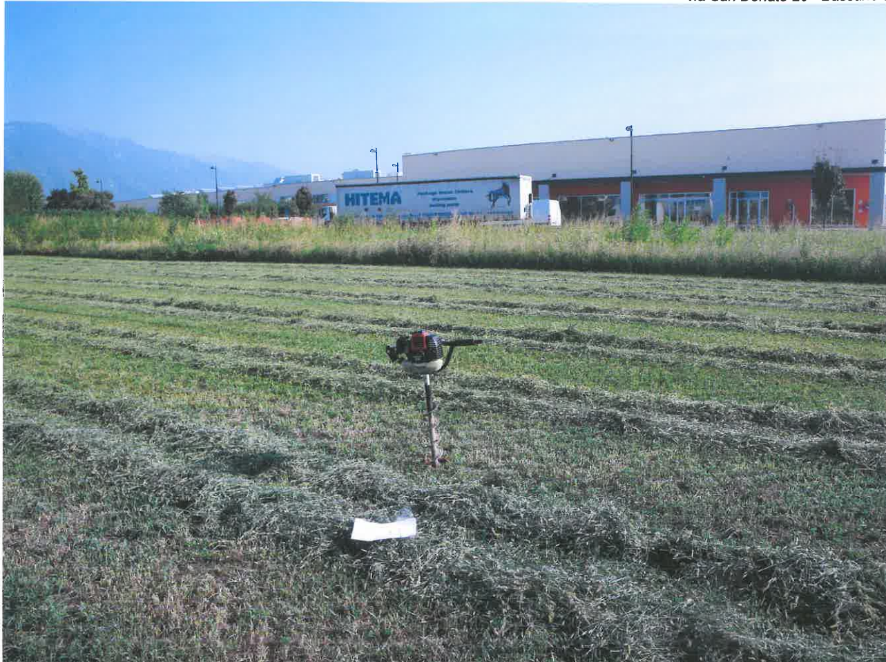
Foto N.5 : Esecuzione del Sondaggio ambientale N.3 con trivella nel settore centrale del fabbricato commerciale
