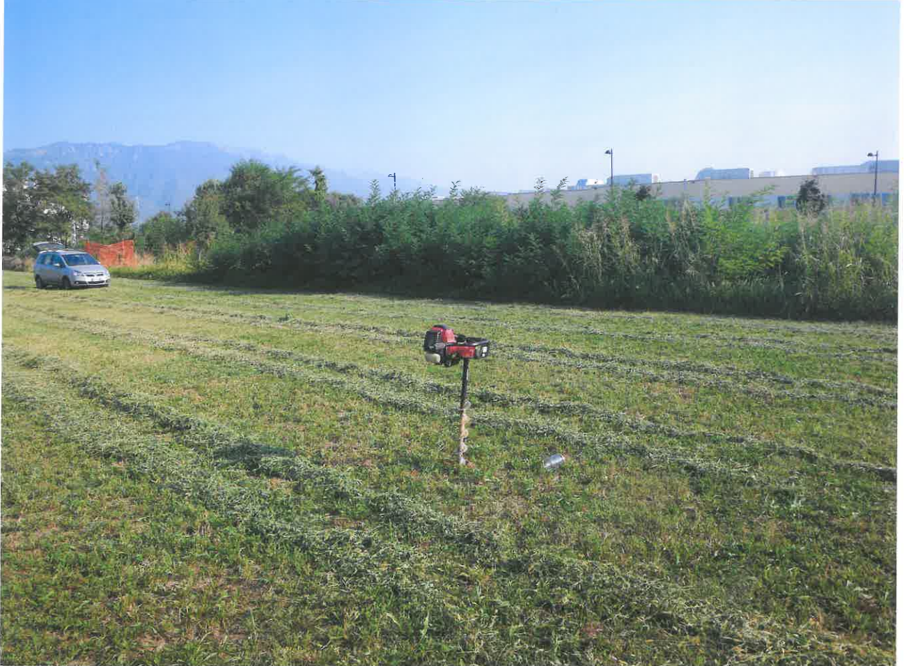
Foto N.3 : Esecuzione del Sondaggio ambientale N.2 con trivella nel settore nord del fabbricato commerciale
