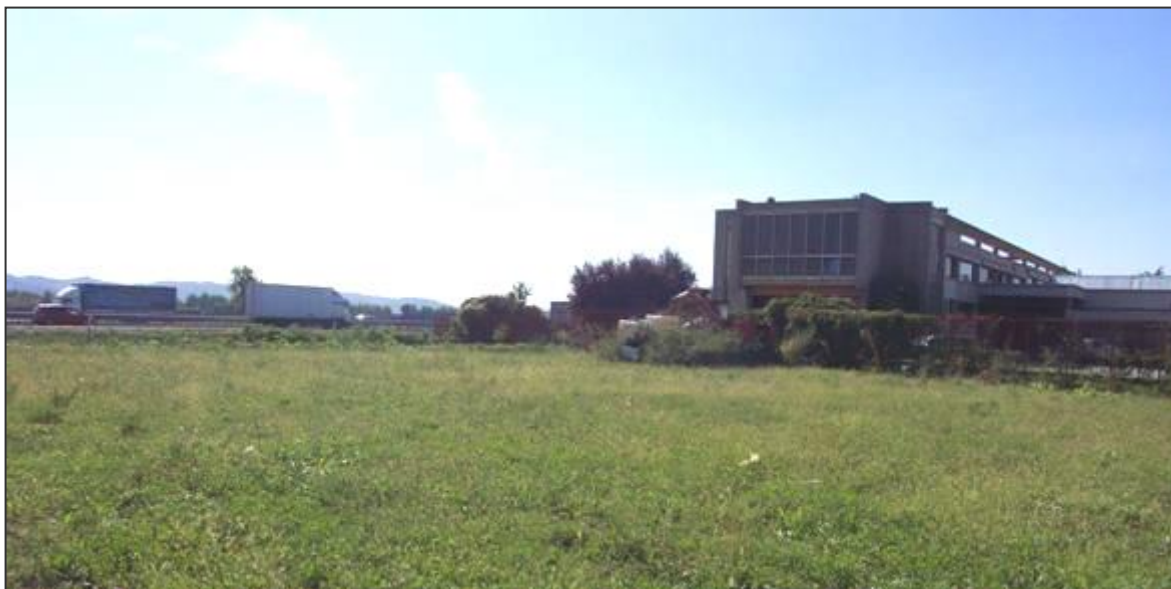
Figura 36 : Autostrada ed altri edifici industriali a confine con la proprietà.
