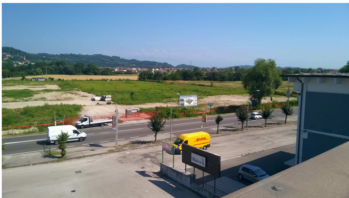
Figura 4.5 – Foto dell'area EST allo stato di fatto (vista da sud)
