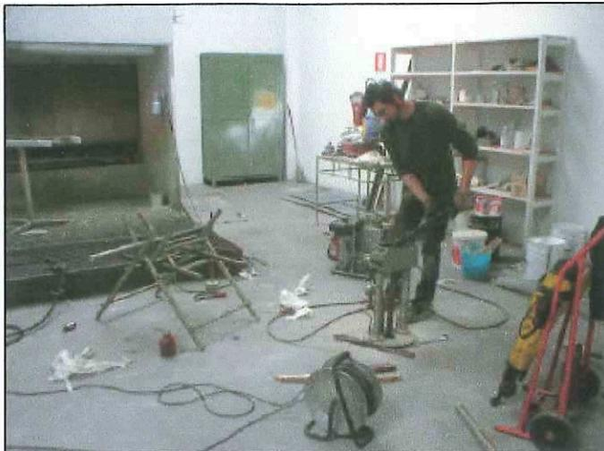
Carotaggio S1 - Operazioni di estrazione aste nella sala di verniciatura.
