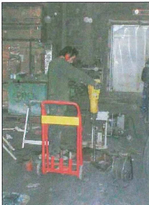
Carotaggio S3 - Operazioni di sondaggio con martello a percussione
