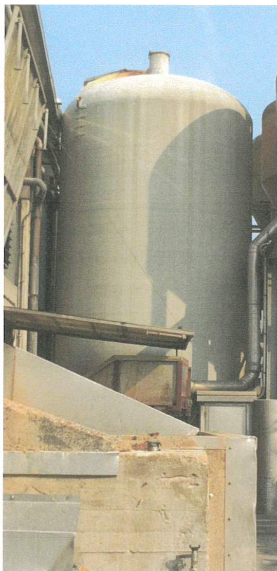
Foto silos S3
