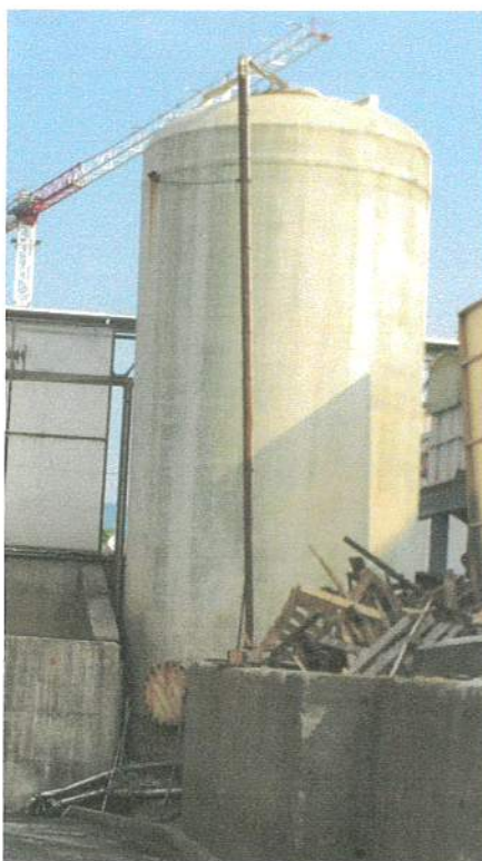
Foto silos S1
