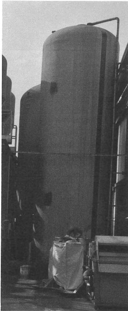
Foto Silos S2
