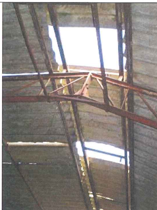
Particolare crepo copertura interna
