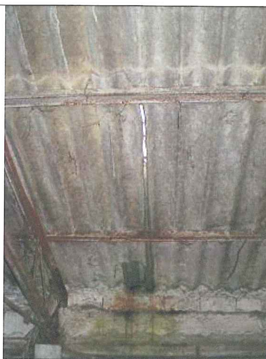
Particolare copertura dall'esterno
