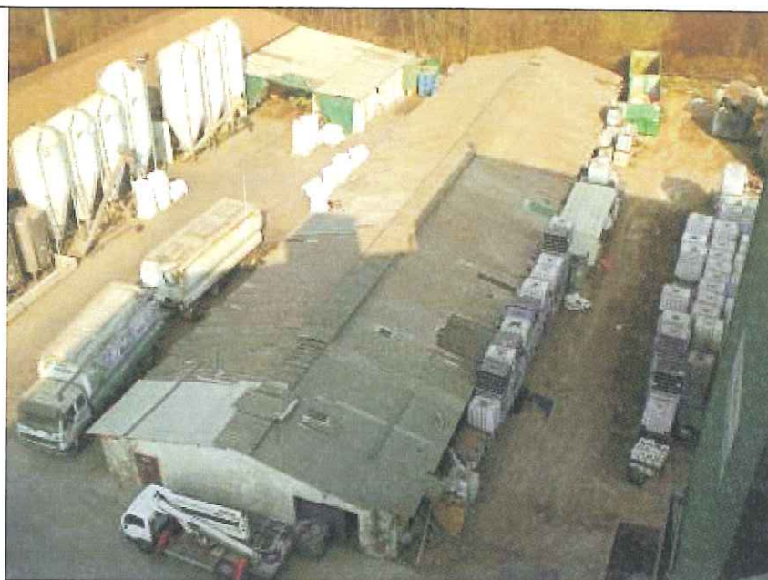
Foto capannone "C" dall'alto
