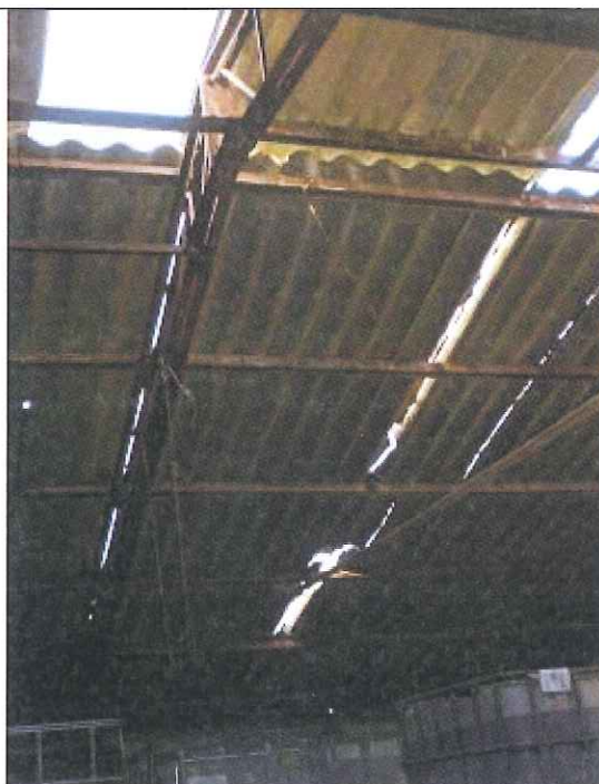
Particolare crepo copertura interna
