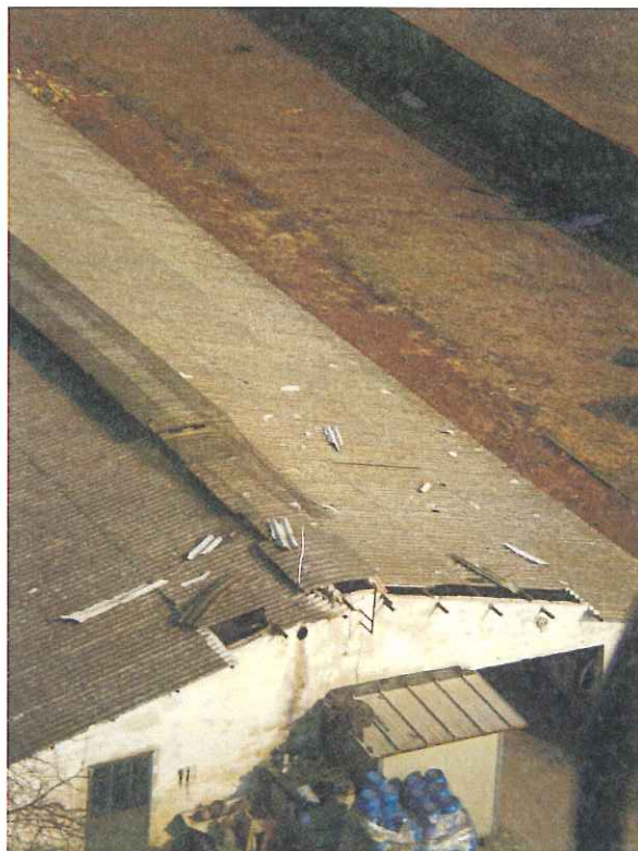
Foto capannone "A" dall'alto
