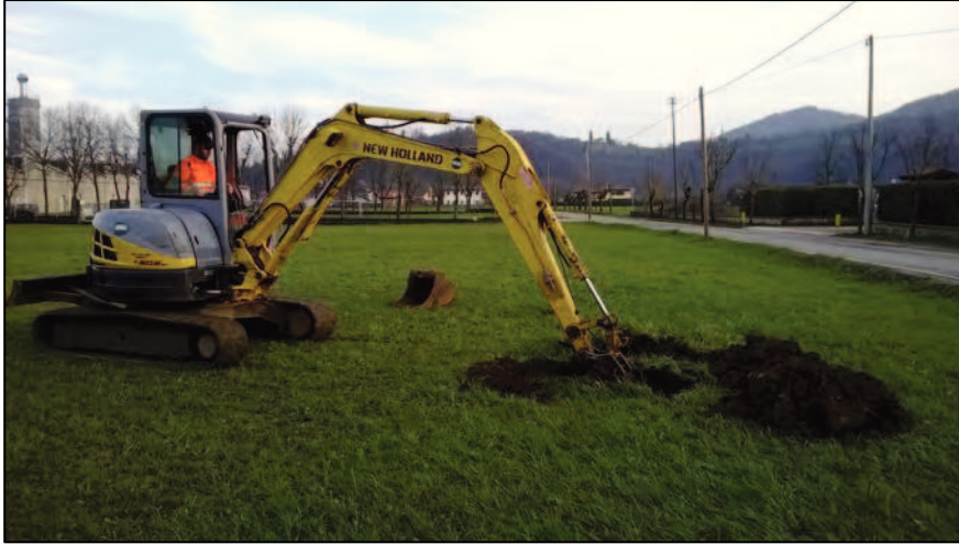
Esecuzione trincea mediante escavatore
