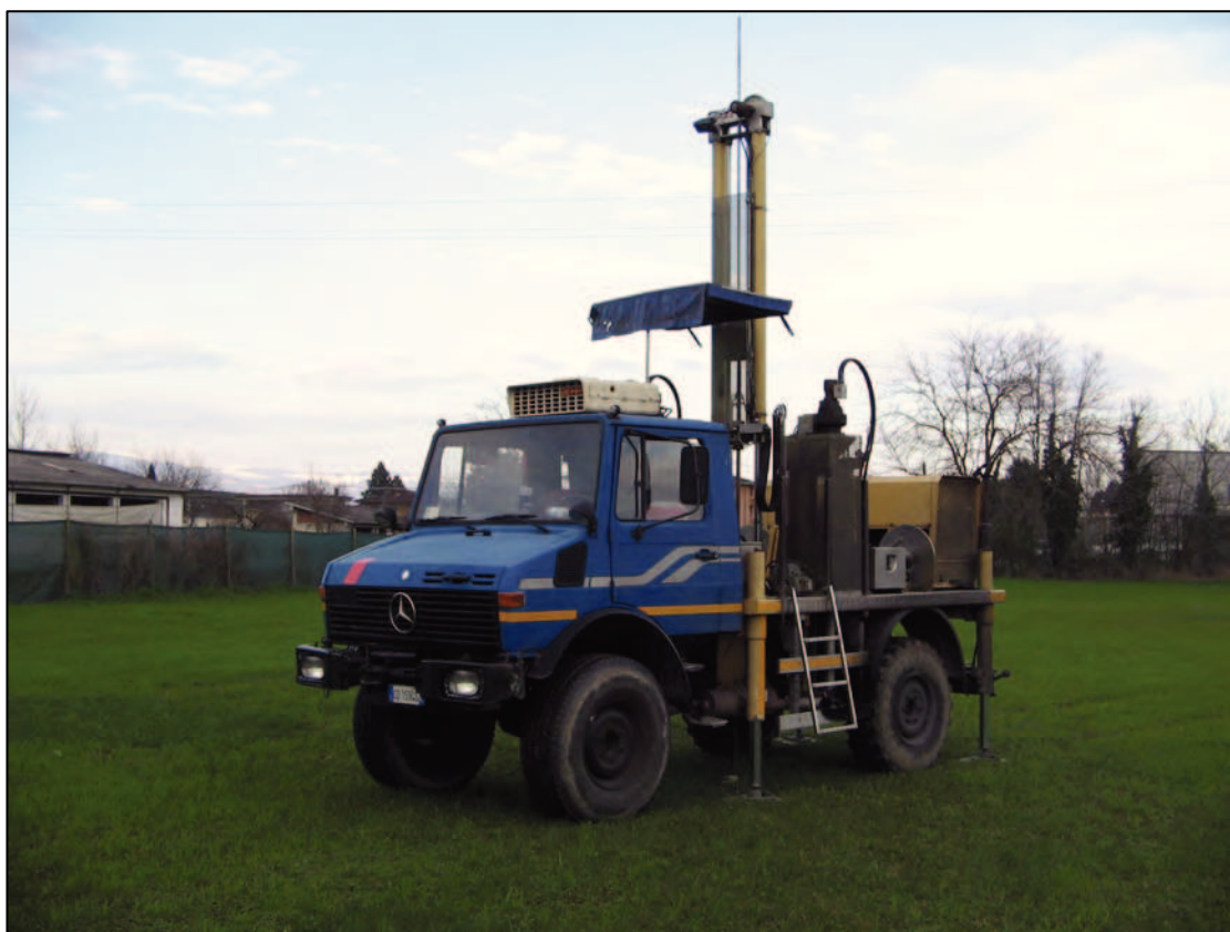
Prova penetrometrica n.5 (effettuata in data 06.03.2014 e quotata a -0,80 m).
