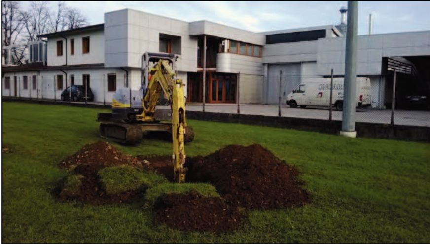
Esecuzione trincea mediante escavatore
