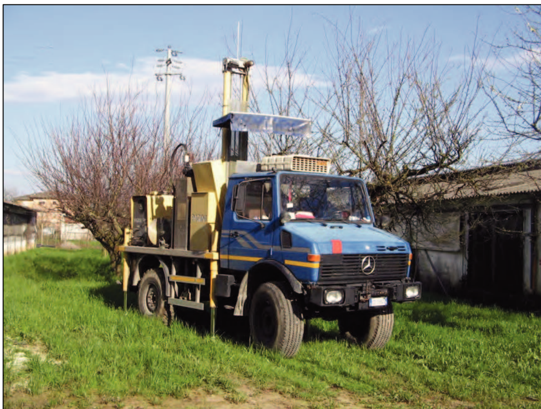
Prova penetrometrica n.2 (effettuata in data 06.03.2014 e quotata a +0,25 m).
