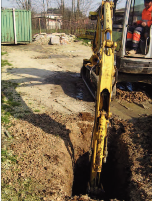
Esecuzione trincea mediante escavatore
