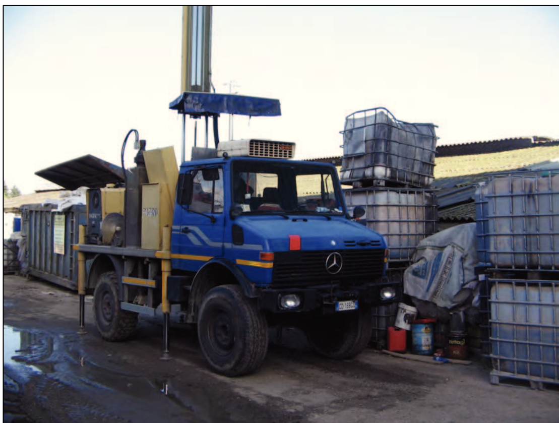
Prova penetrometrica n.1 (effettuata in data 06.03.2014 e quotata a +0,39 m).
