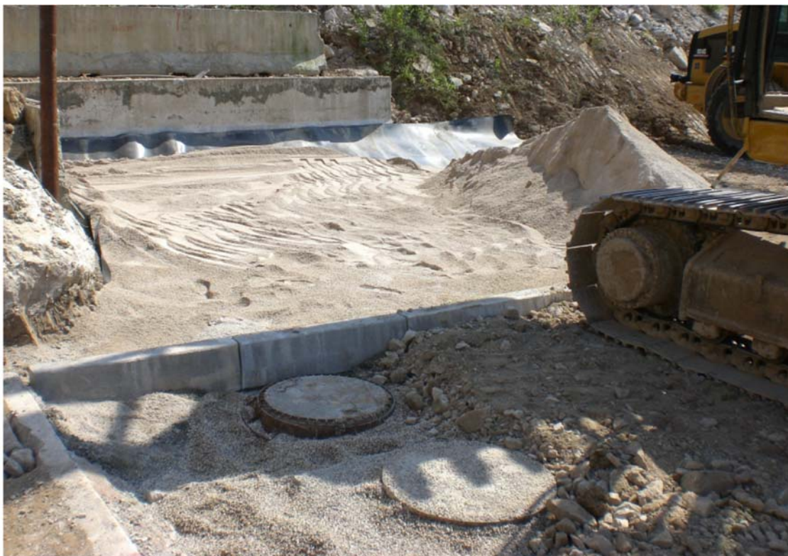
Foto 3: Cordolo, stabilizzato e pozzetti.
