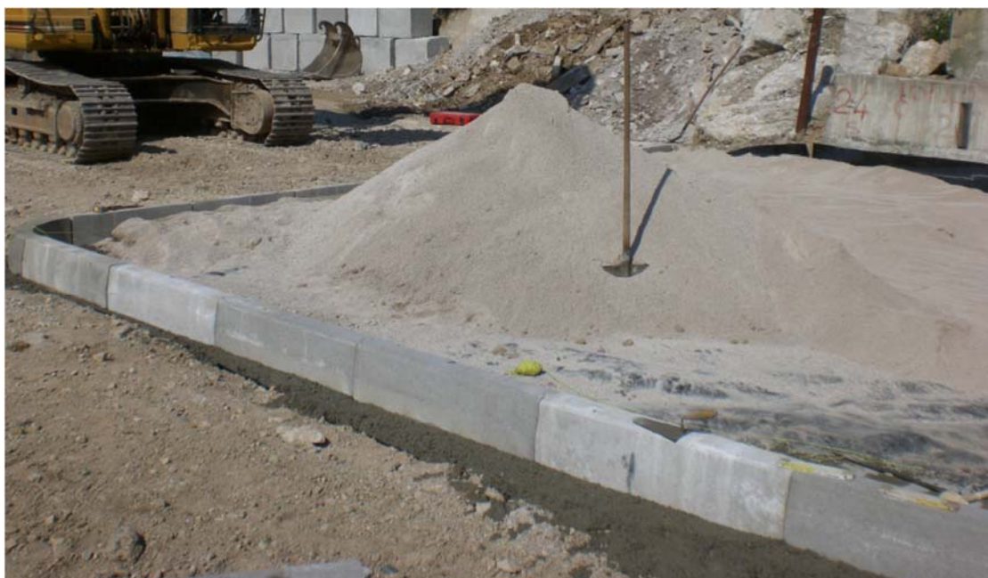
Foto 2: Cordolo e stabilizzato
