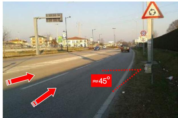
Figura 5.2 – Angolo di installazione dei radar rispetto alla direzione di marcia
