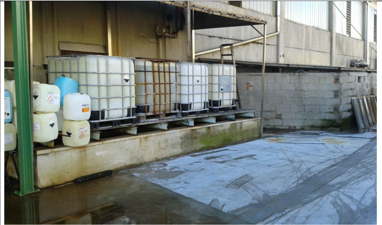
Foto 1: Pavimentazione fronte nord (ripristinata)
