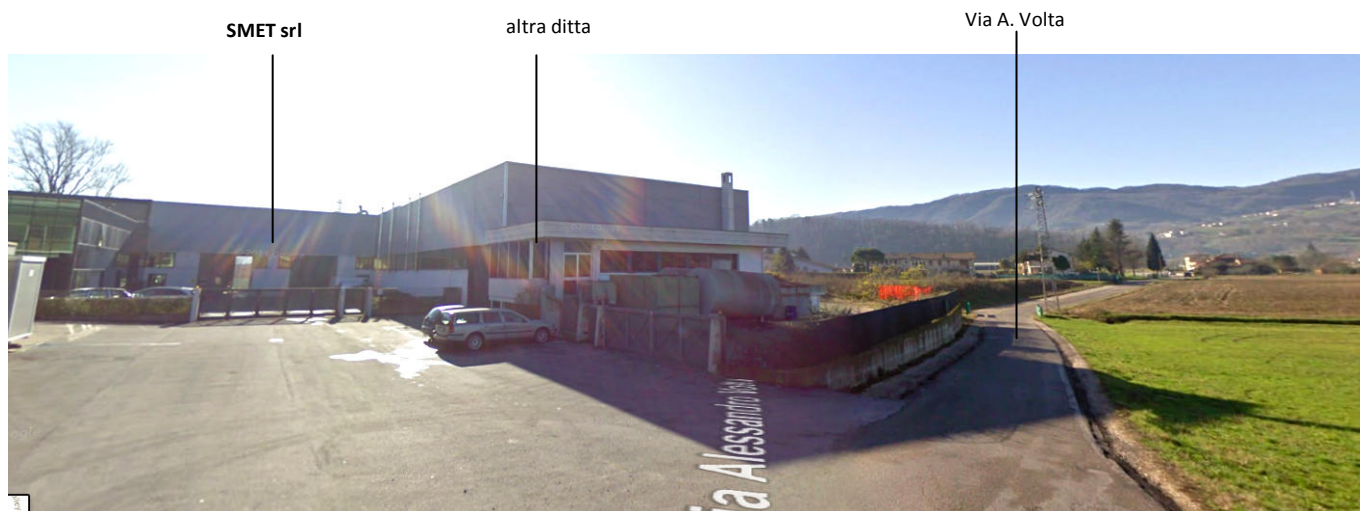
Figura 80: Panoramica del sito aziendale della SMET srl.
