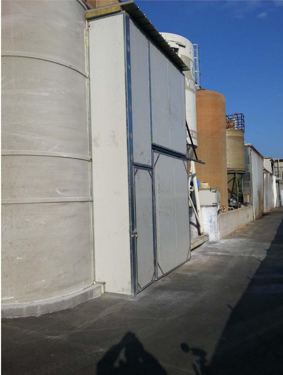
Foto ventilatore con cabina fonoisolante
