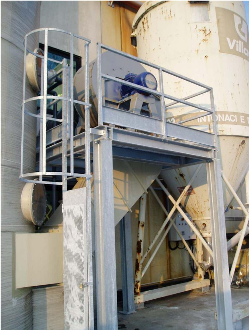
Foto ventilatore senza cabina fonoisolante
