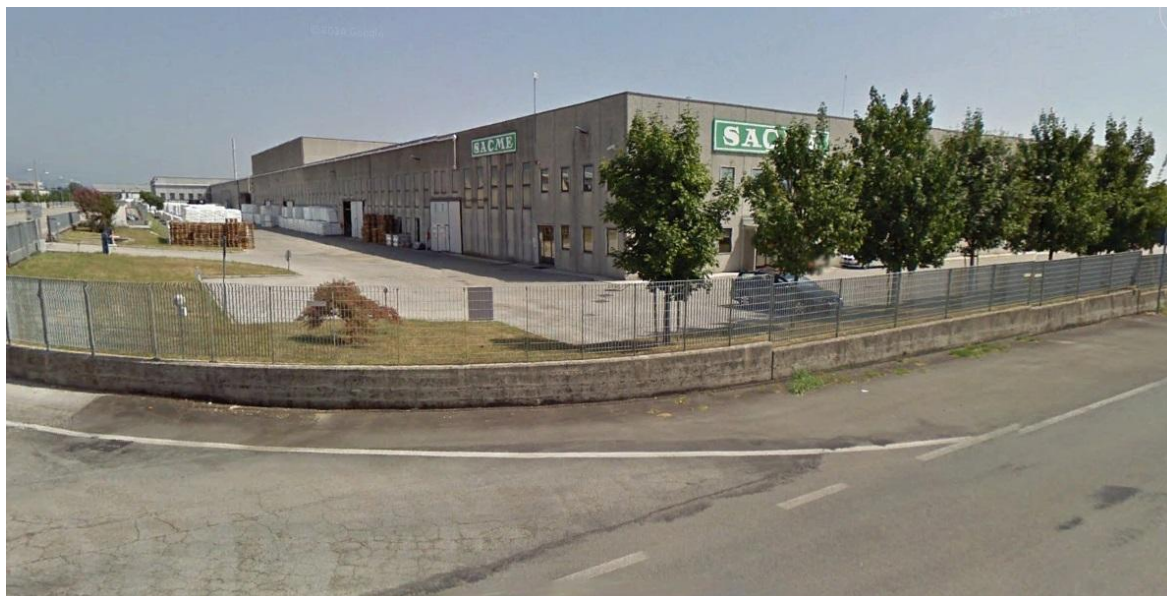
Figura 12: Vista del capannone della ditta SACME.
