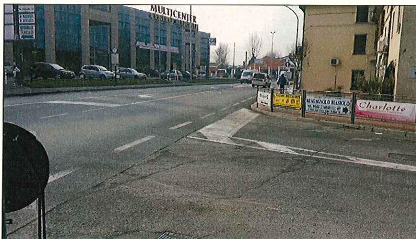
Attuale intersezione tra S.R. 11 e Viale Italia
