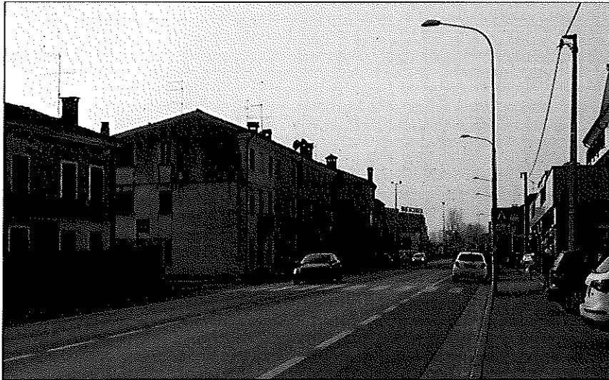
Attraversamento stradale esistente localizzato tra Viale Italia e Via Trieste
